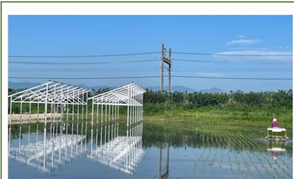
水田での杭架台の標準化
